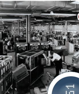
• **La computadora 1401** reemplaza los tubos de vacío por los transistores y su memoria es de núcleos magnéticos.
